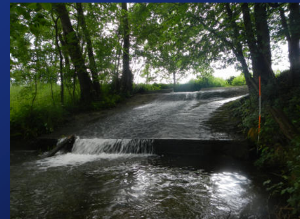
Stat. km 1+620 (Wehr Obermühle)
