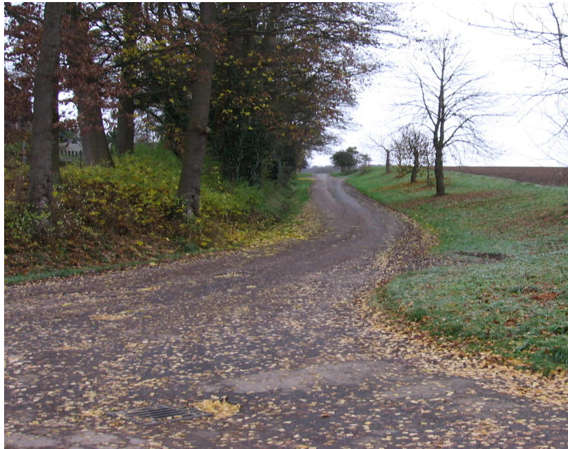
Asphaltweg Nr. 185 in Richtung Südwesten (geplant: Erneuerung und Verbreiterung)
